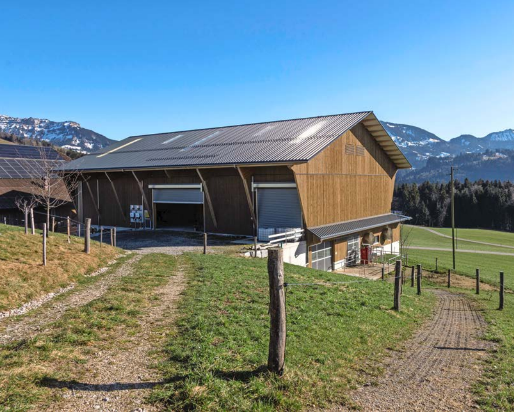
Der Stall ist deckenlastig gebaut. Das Futterlager sorgt für ein angenehmes Klima im darunterliegenden Stallbereich.
